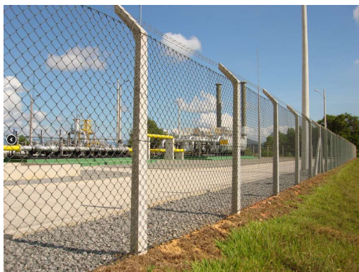
Fechamento perímetro externo: Mourão de concreto e alambrado.
